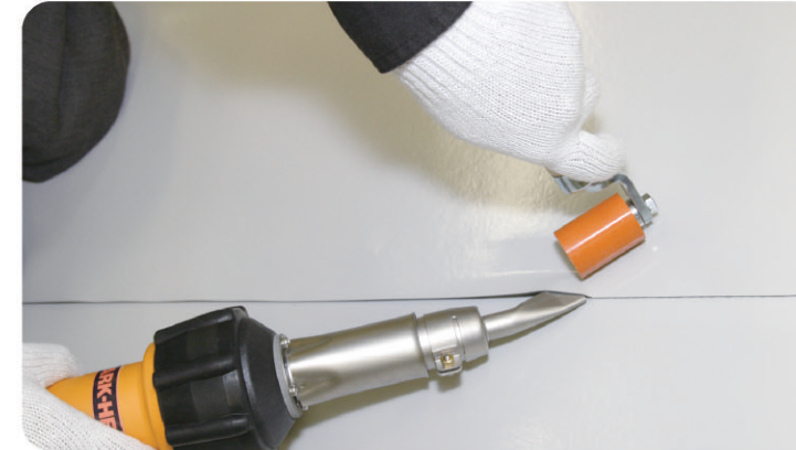
テントシートの幅接ぎ・補修
